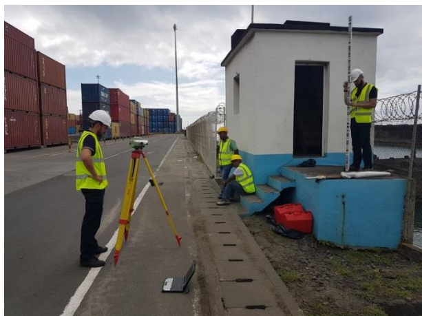
Nivellement des repères de l'observatoire
